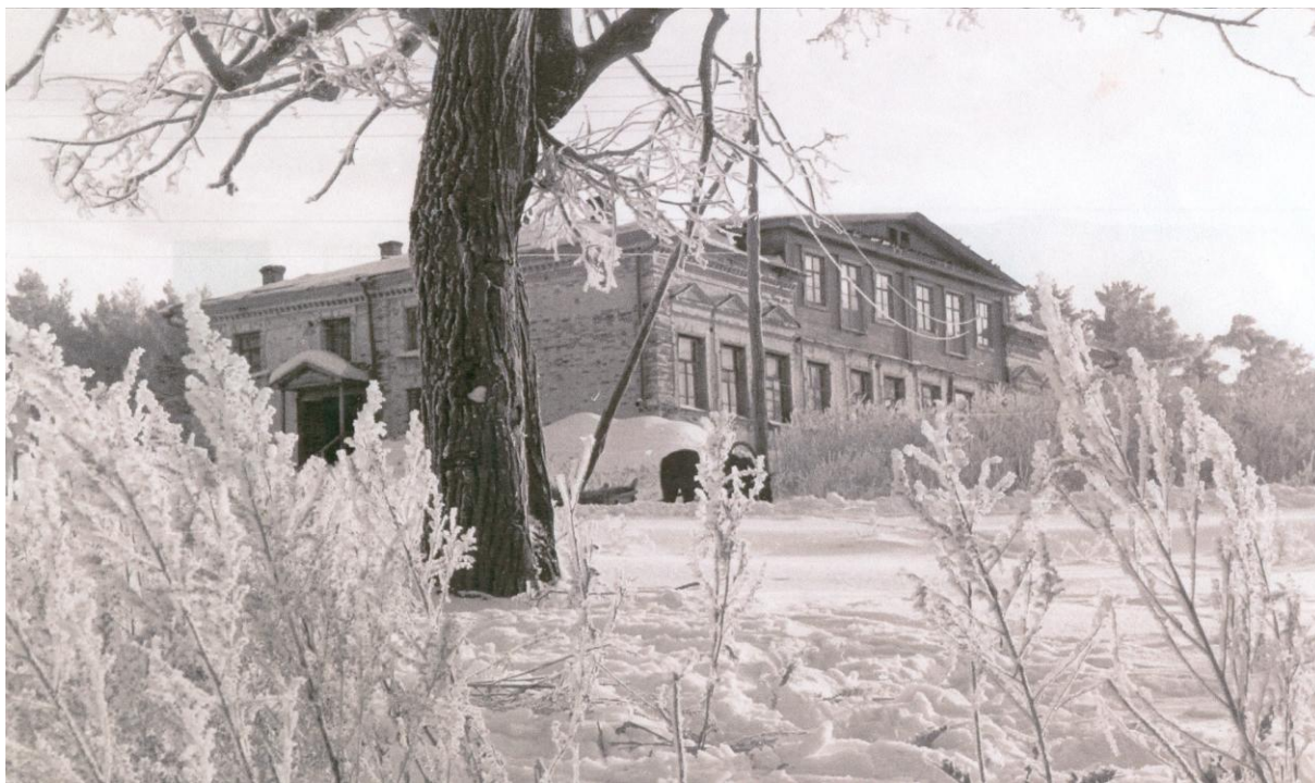
Рис. 3 Историческая фотография здания из архива Администрации муниципального района Иса克林ский Самарской области
